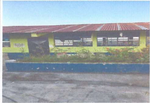
Foto 2: Cambio de techo aulas y cocina
