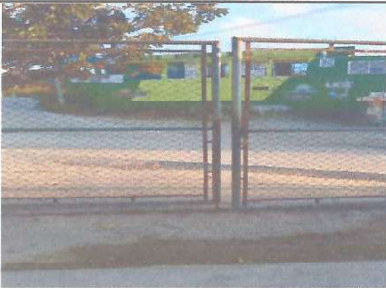
Foto 3: Mejoramiento de Porton principal
