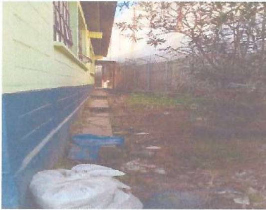
Foto 1: Mejoramiento del Muro Perimetral
